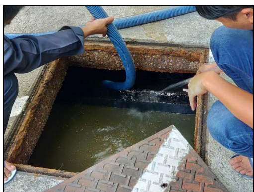
รูปที่ 11 (ต่อ) การสูบน้ำออกจากระบบบำบัดของโครงการ ประจำปี 2568
