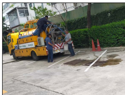
รูปที่ 11 (ต่อ) การสูบน้ำออกจากระบบบำบัดของโครงการ ประจำปี 2568
