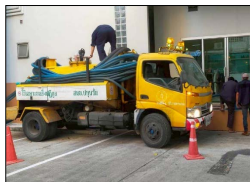
รูปที่ 11 การสูบลบตะกอนระบบบำบัดของโครงการ ประจำปี 2568
