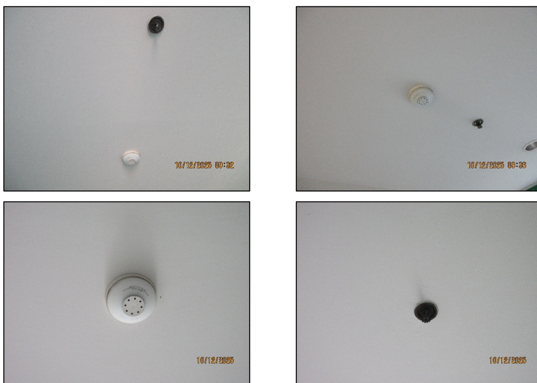
รูปที่ 43 อุปกรณ์ตรวจจับควัน / ตรวจจับความร้อน
