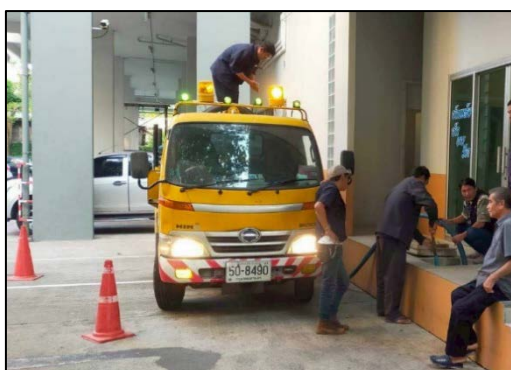
รูปที่ 11 การสูบลบตะกอนระบบบำบัดของโครงการ ประจำปี 2568
